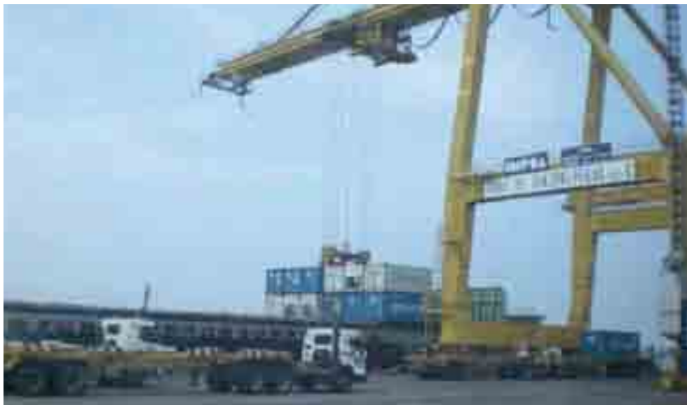
Gambar 1.4 Penanganan bongkar muat dengan alat bantu bongkar di darat pada pelabuhan Tanjung Perak Surabaya, Indonesia. jenis Transtainer.
