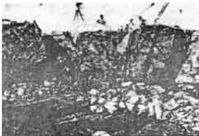
Gambar 5.42 penempatan / penumpukan batu di lokasi setelah lapisan inti
