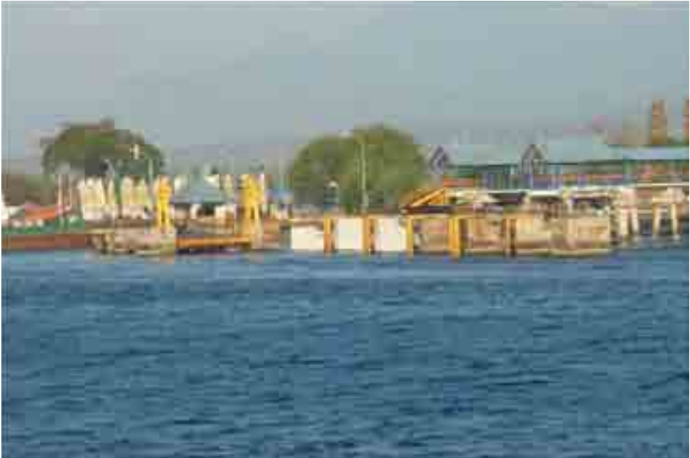
Gambar 6.8 Breasting dolphin dan mooring dolphin menyatu pada dermaga pelabuhan penyebrangan Gilimanuk Bali
