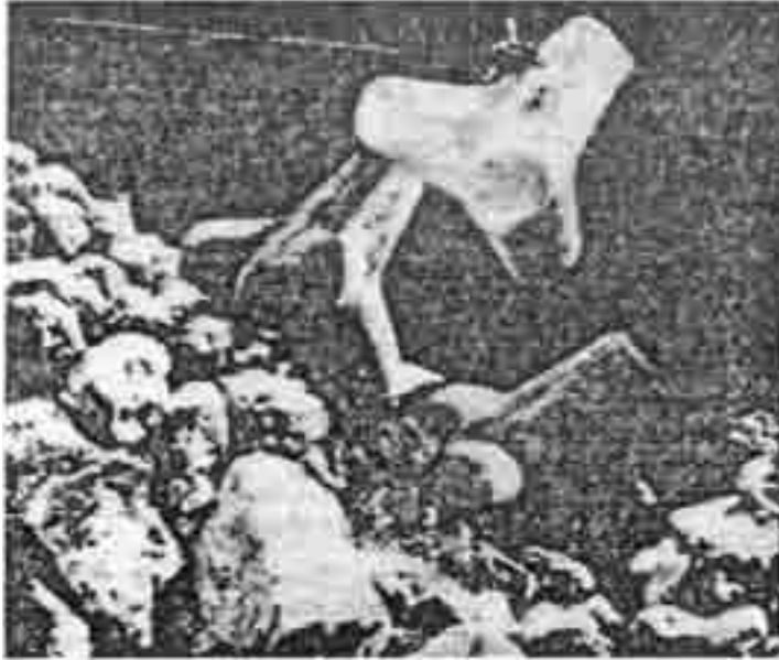
Gambar 5.57 Penempatan tetrapod pada lapisan pertama diatas tumpukan batu
