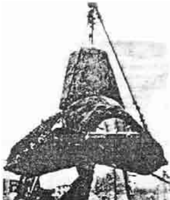
Gambar 5.56 Cara pengangkutan tetrapod
