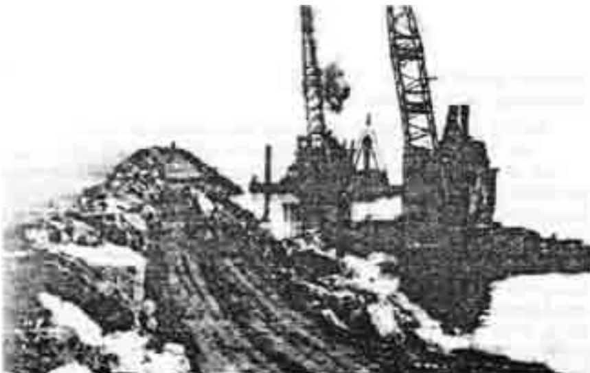
Gambar 5.44 Penumpukan batu dengan menggunakan Derek
