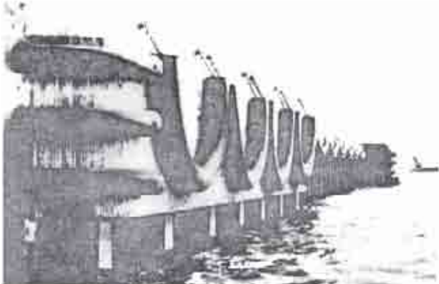
Gambar 6.35 sistem fender karet digantung di pelabuhan minyak Puerto La Cruz Venezuela
