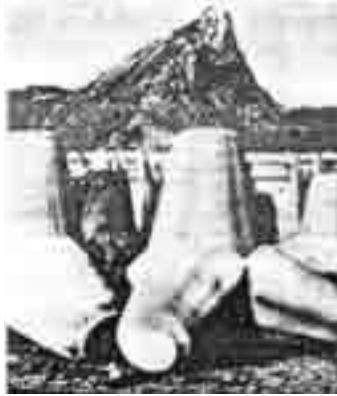
Gambar 5.55 Tetrapod untuk unit lapisan luar pemecah gelombang ( NEYRPIC, Grenobel, France).
