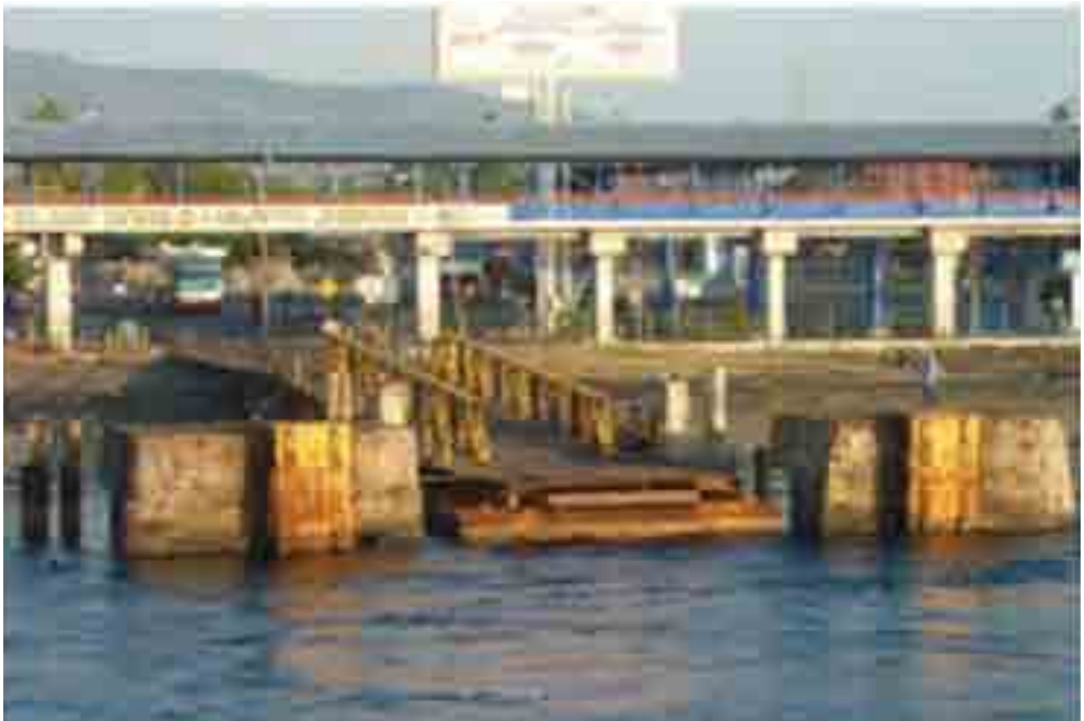
Gambar 6.7 Breasting Dolphin dan Mooring Dolphin (sudah tidak ada/hancur) Pelabuhan penyeberangan Gilimanuk saat ini
