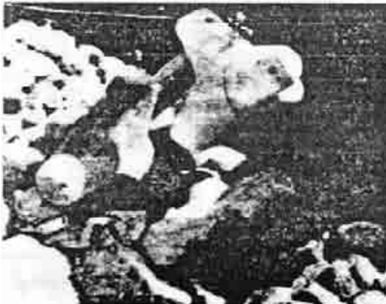
Gambar 5.58 penempatan tetrapod pada lapisan kedua
