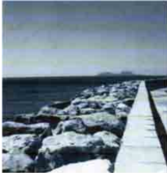
Gambar 5.30 Pemecah gelombang dengan crown wall yang sejajar dengan rock armour
