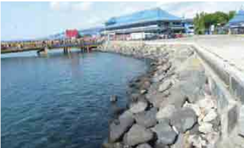
Gambar 2.36 Bangunan sisi miring pada pantai pelabuhan penyeberangan Ketapang, Banyuwangi
