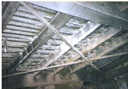
Gambar 1. Jembatan Tukad Bindu di Denpasar-Bali. Gambar kiri: Tampak bawah CSD. Gambar kanan: Tampak atas kerusakan pelat dengan pelat baja untuk menahan beban lalu-lintas sementara.
