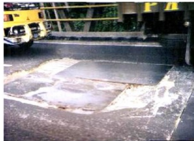
Gambar 1. Jembatan Tukad Bindu di Denpasar-Bali. Gambar kiri: Tampak bawah CSD. Gambar kanan: Tampak atas kerusakan pelat dengan pelat baja untuk menahan beban lalu-lintas sementara.
